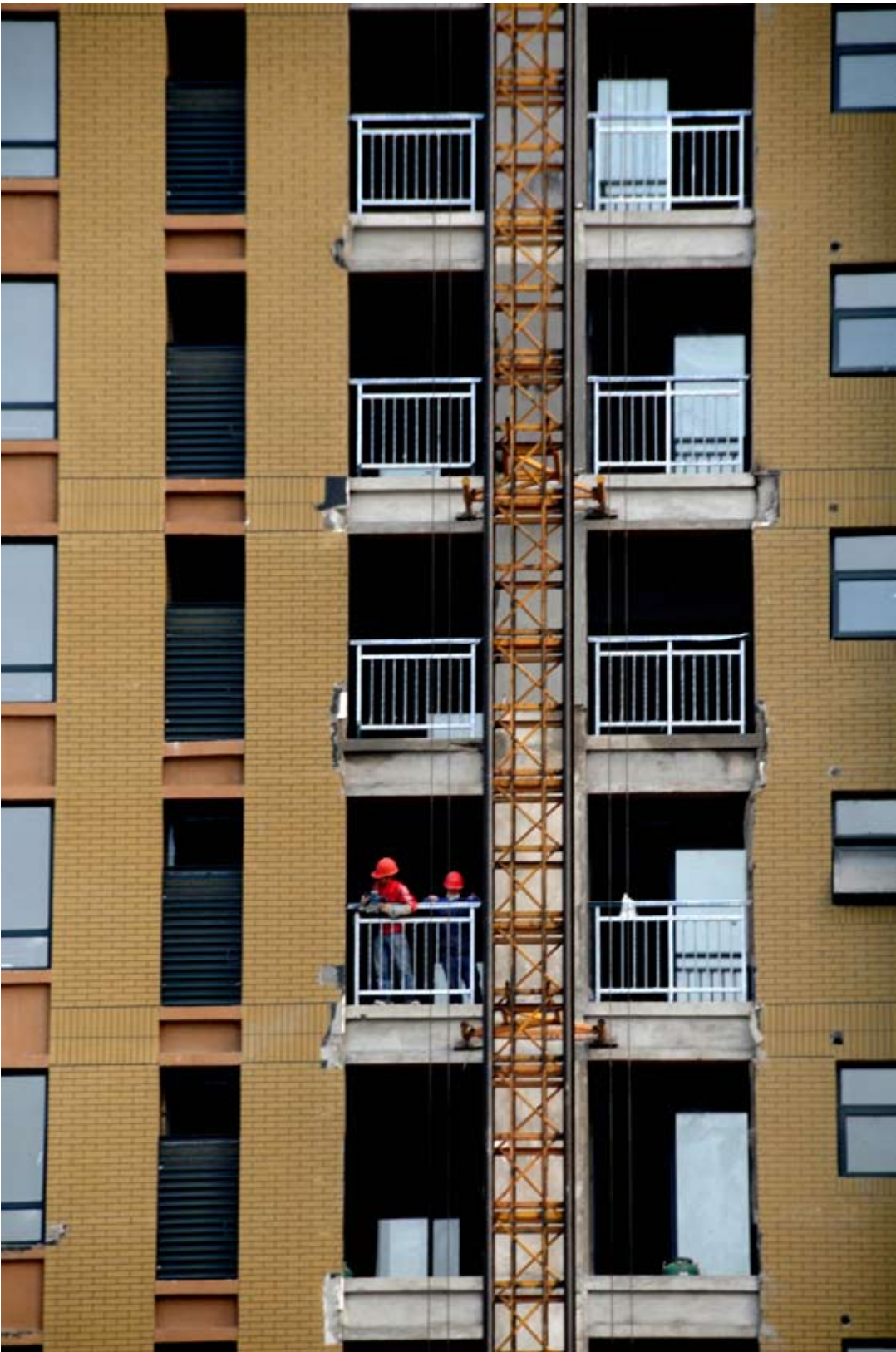
[ 建 ] 工地是这个城市寻常的街景。在中环城CD地块，钢筋水泥架构的躯体上空，几只巨大的铁臂，悠来晃去，一斗斗沙浆提上去、一捆捆钢筋颤抖着。明天的明天，这里又是一苑新区，一个崭新的美好家园。
