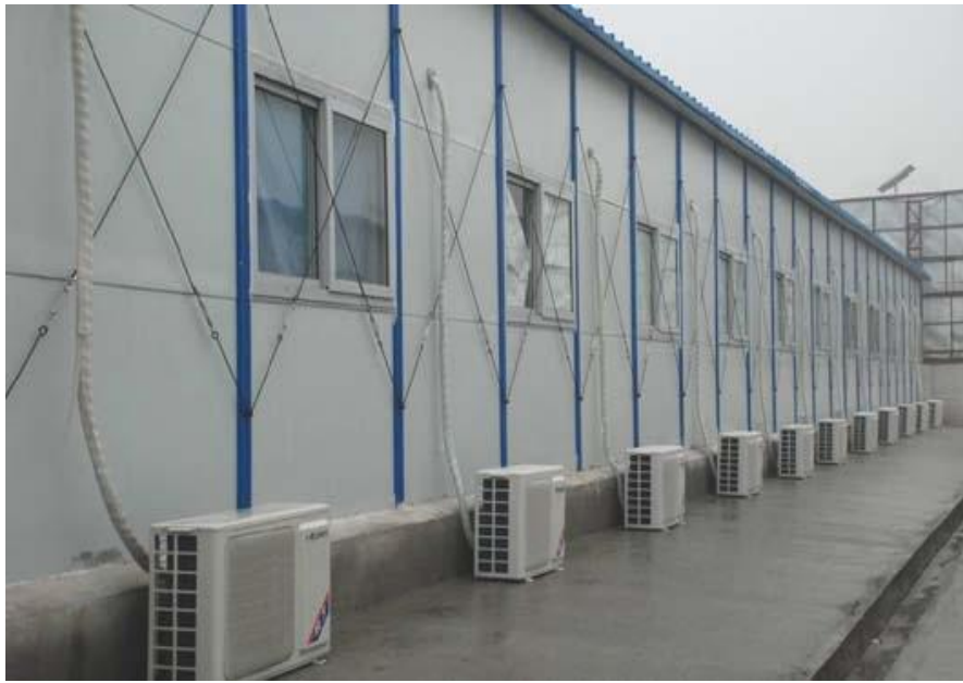
图 | 2010年11月，中环城项目工地农民工宿舍外
